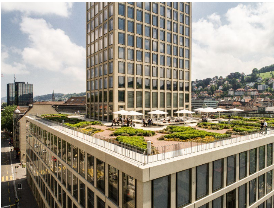
Abbildung 1: Gebäude Ostschweizer Fachhochschule
