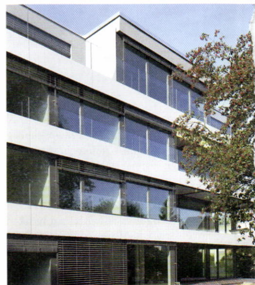
Neubausiedlung Mötteliweg mit Antrieben und Steuerungen von elero.
